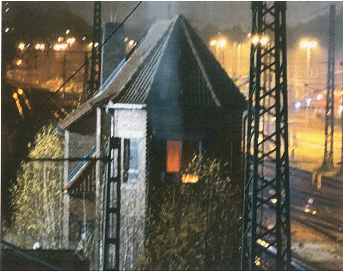
Es brannte im Obergeschoss des ehemaligen Stellwerks. Fotos: VG VG 25.11.2020 18.54
