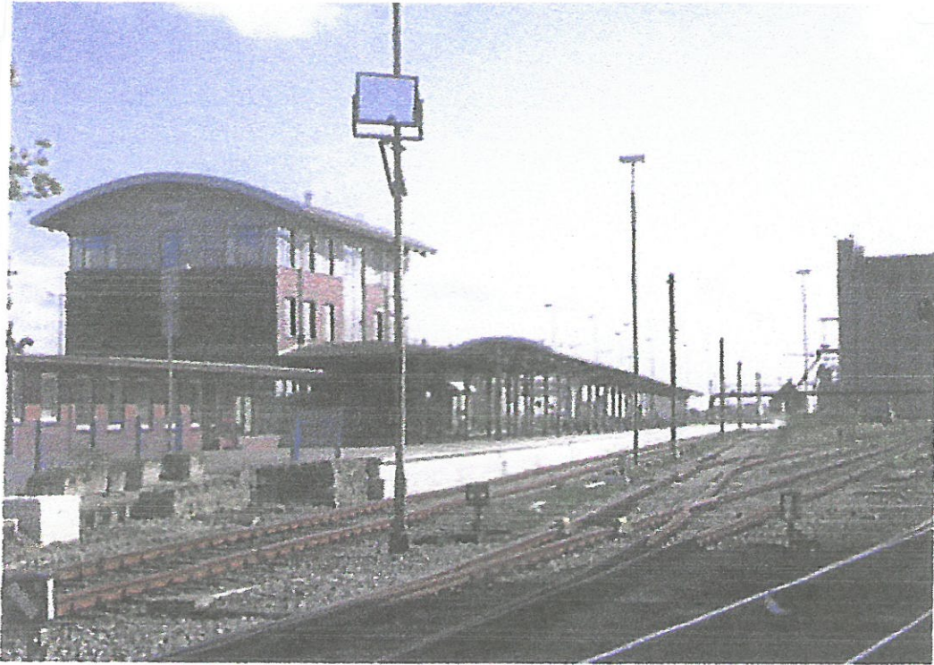
Bahnhof Emden Außenhafen vor der Elektrifizierung
