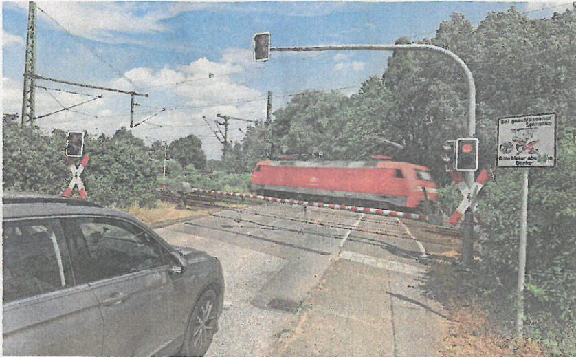
Der Bahnübergang an der Teerhofsinsel soll geschlossen werden.
