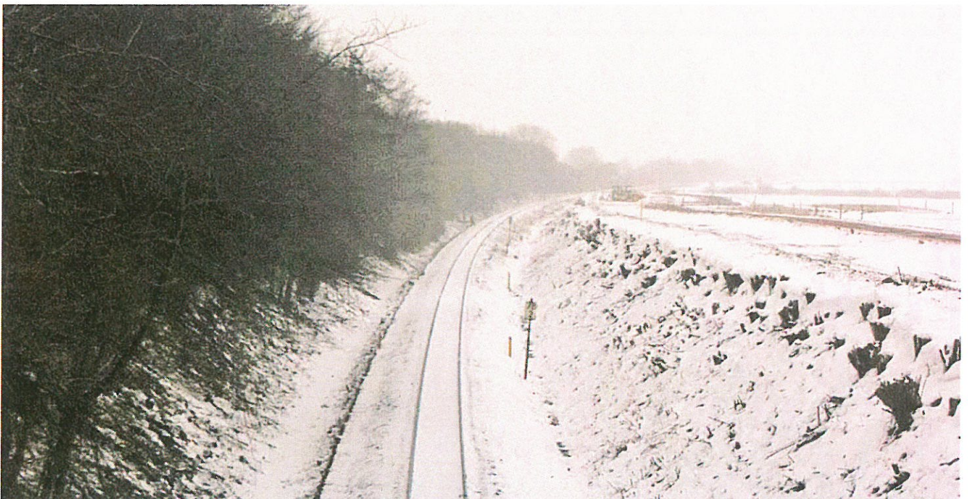
Die eingleisige Bestandstrasse wird zweigleisig ausgebaut und elektrifiziert. © Andreas Höppner
