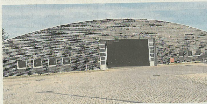
Der Betriebshof der LVG in Travemünde kann die hohen Brandschutzanforderungen für Elektrobusse nicht erfüllen.
