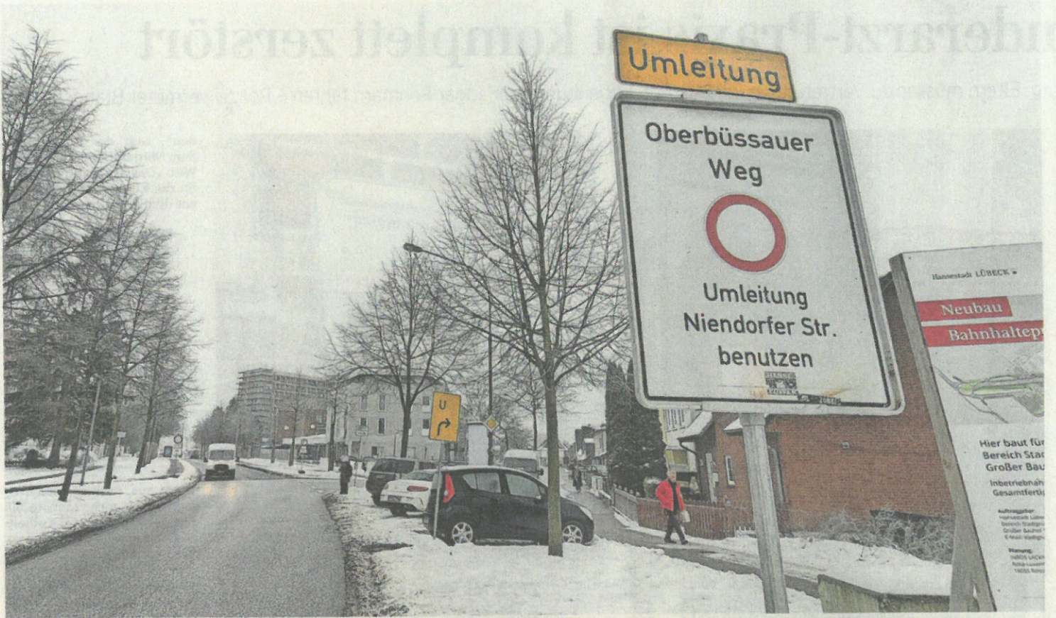
Wegen Bauarbeiten ist der Bahnhof Moisling für private Autofahrer nicht zu erreichen. Die Stadt Lübeck hat eine entsprechende Beschilderung erneuert.
