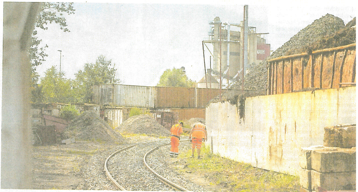
Beim Zementwerk Lübeck im Herrenwyk sind die alten Gleise erneuert worden. Bald sollen dort wieder Züge fahren.
