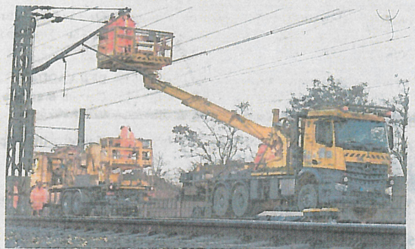
Mit dem „Schörling“, der auf Straße und Gleis fahren kann, wurde der Fahrdrat für den elektrischen Strom der Loks während der Bergung verschwenkt.
